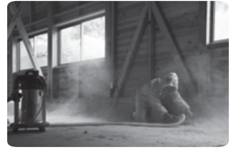
新しい農業研修棟の床から放射性部質に汚染されたコンクリートを削る
