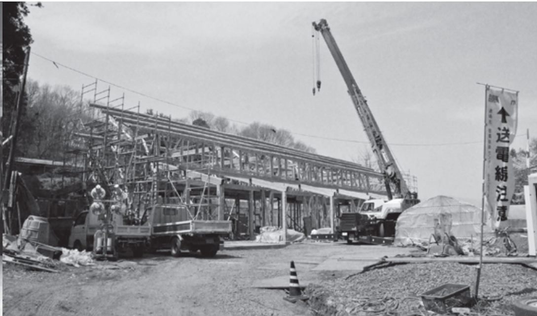
建築中の農業研修棟
